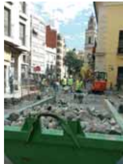
Les obres ja estan en marxa
